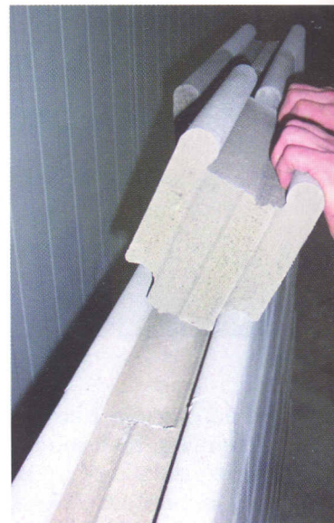
Door de speciale vorm klemt het LockBlock zich op zijn voorgangers.
