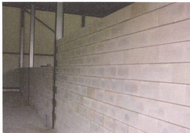
Fase 1 bedrijfsverzamelgebouw in Ter Apel. Fase 2 nu in opbouw
