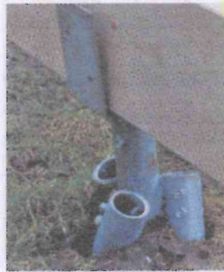
Het mega-anker zit in de grond en kan direct worden belast.
