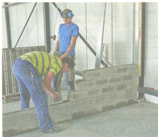
De uitvoering van een binnenwand met Lockblock-elementen van BIA Beton.
