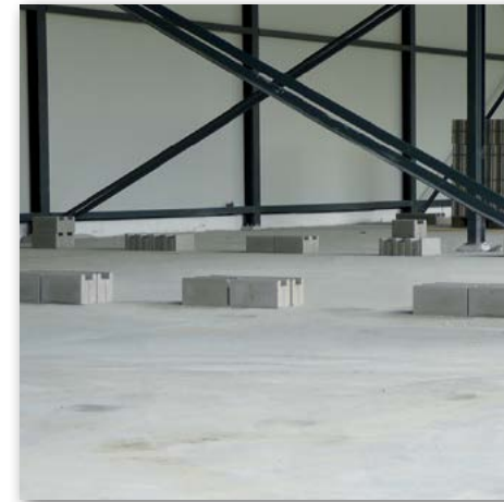
Zetten van de eerste kimlaag
