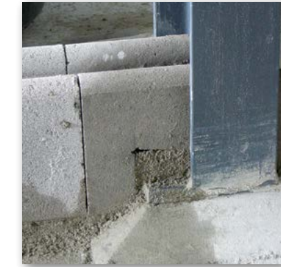
Kimlaag en aansluiting stalenprofiel
