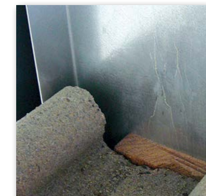
Vastzetten met houten keg
